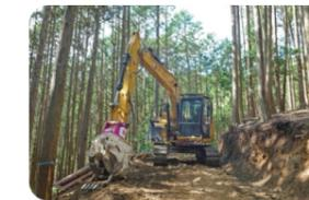
効率的かつ持続的な森林整備を行うためには林道（森林作業道）の整備が必要不可欠です。安全性と経済性を確保しつつ、地形を活かした設計を行い、地質、傾斜などを踏まえて、災害に強く、繰り返し使える作業道を開設致します。
